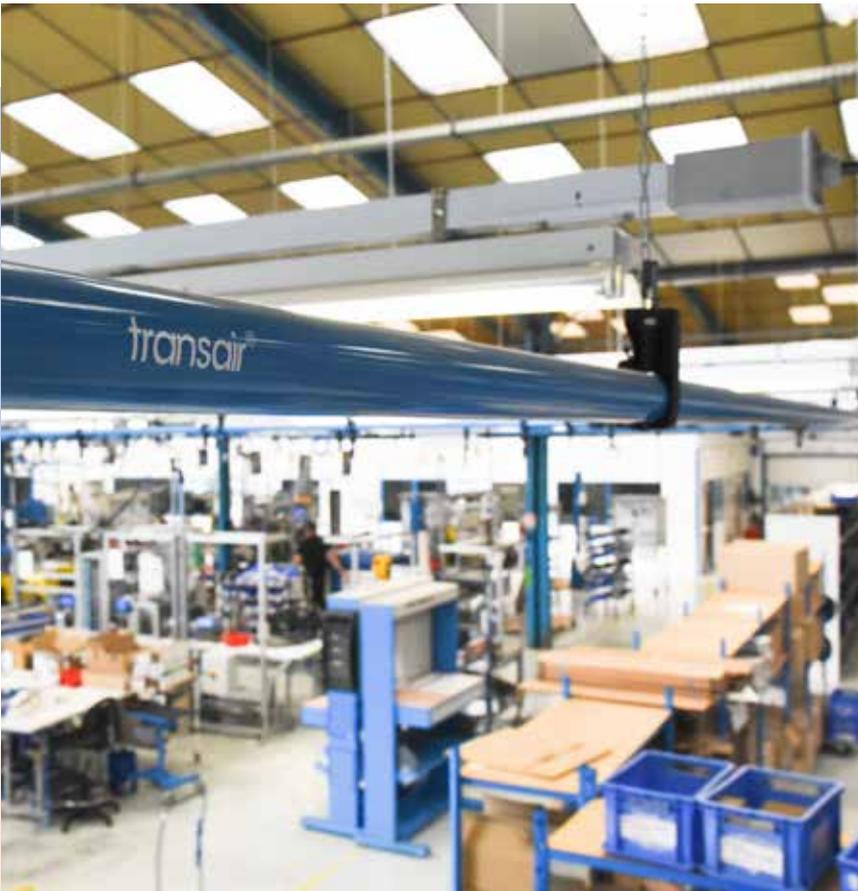
Conforme a la Euroclase EN13501-2, la gama de aluminio Transair®, equipada con una solución específica, es un pasaje de conductos ignífugo que evita la propagación de cualquier incendio y resiste durante 120 minutos (E120)\*.
